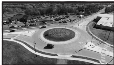
Stearns County CSAH 2 Roundabout
